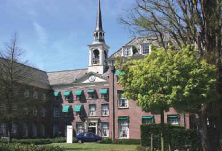
DE CENTRALE KEUKEN RIJNLAND CUISINE WAS GEDURENDE ANDERHALF JAAR GEVESTIGD IN HET MONUMENTALE PAND VAN WMV IN WARMOND.
